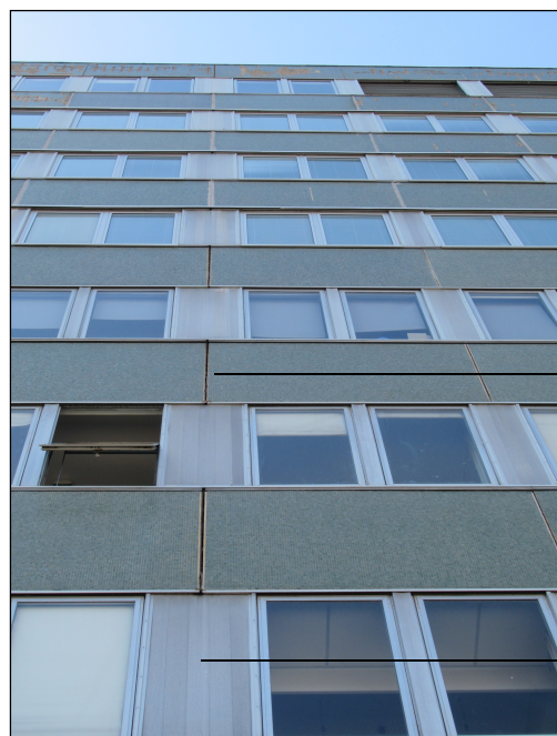
Joint entre les panneaux préfabriqués des allèges.
