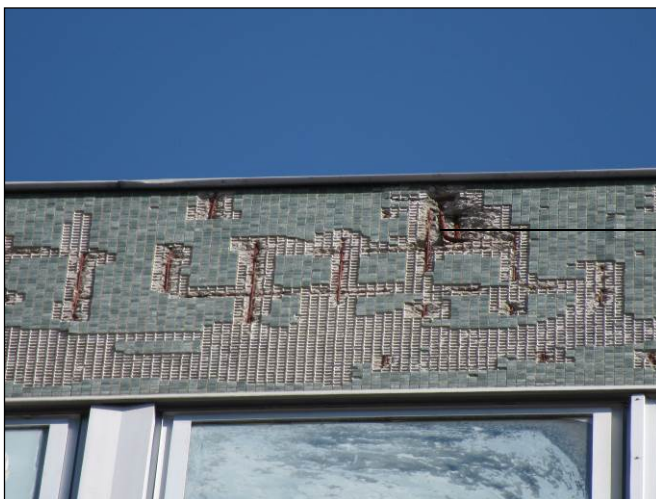
Eclats du béton d'enrobage.
