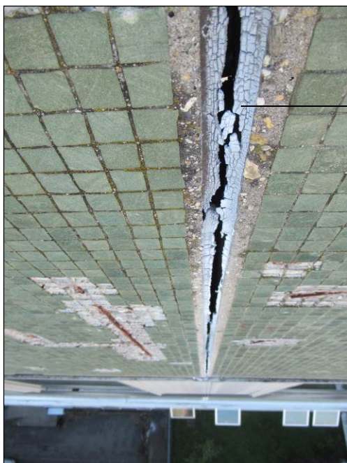
Joint altéré.
