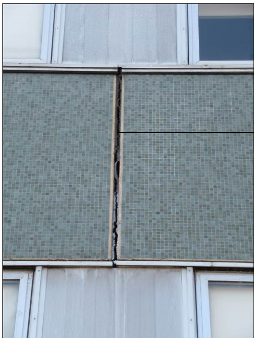
Joint d'étanchéité dégradé.
