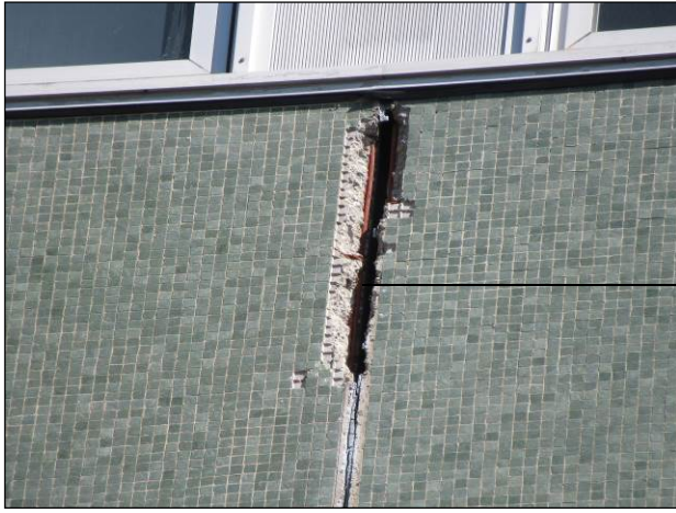
Béton dégradé en bords de panneaux.
