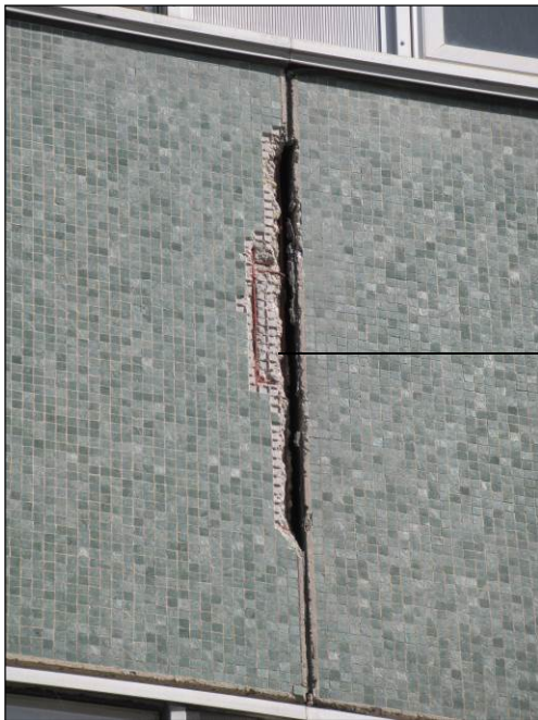
Dégradation au droit des becquets, de faible épaisseur, passant devant les têtes des poteaux.
